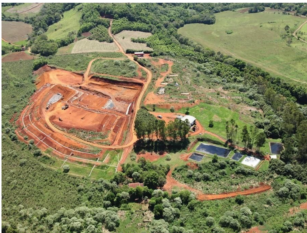
Figura 4-2. Aterro Sanitário Unidade I – TOS Ambiental – Saudades/SC
