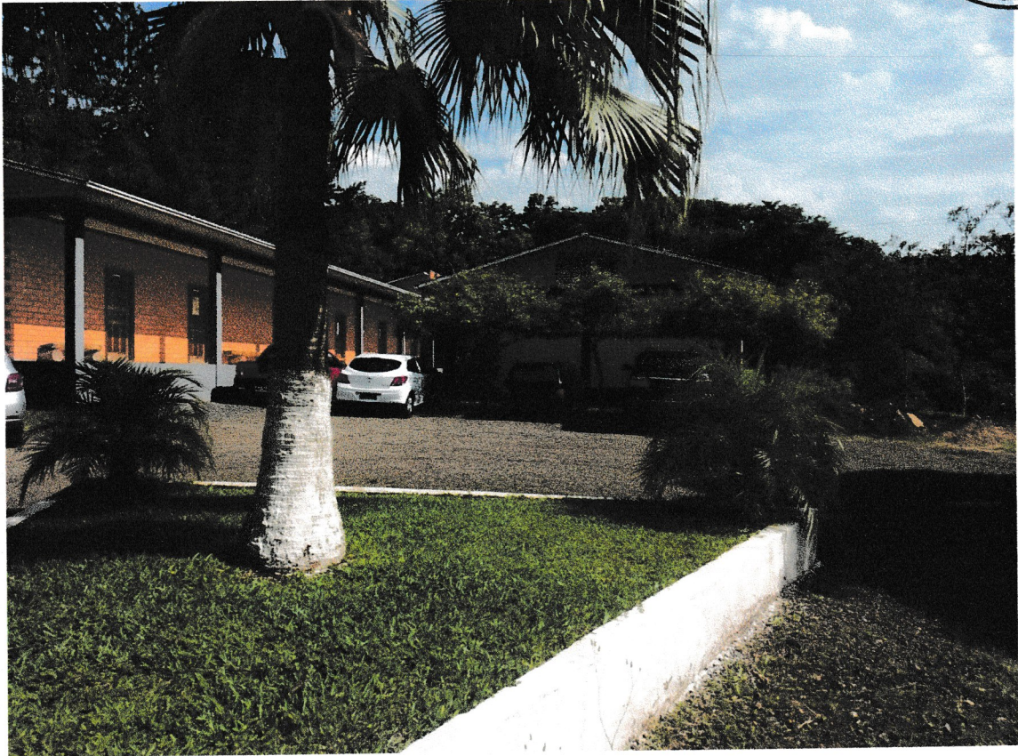
Figura 01: visão externa da Casa Familiar Rural
