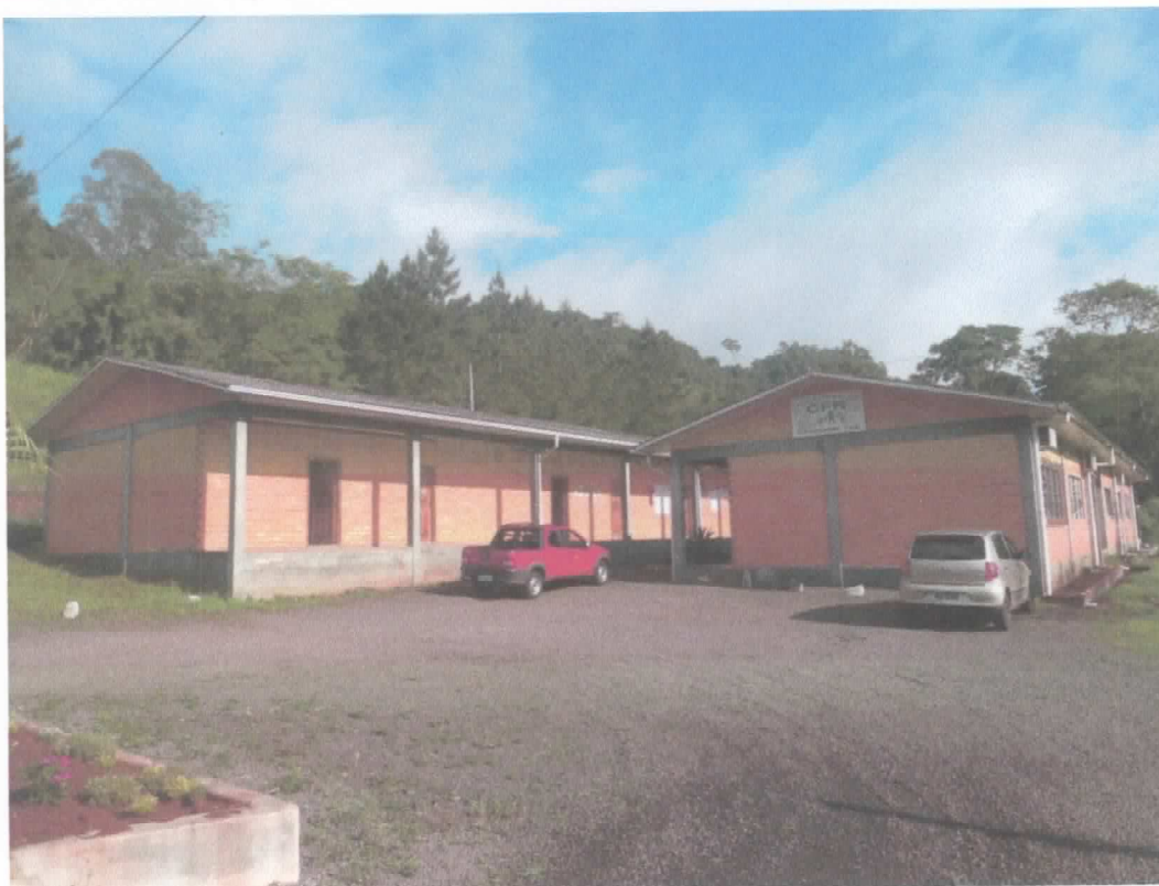
Figura 01: Visão externa da Casa Familiar Rural
