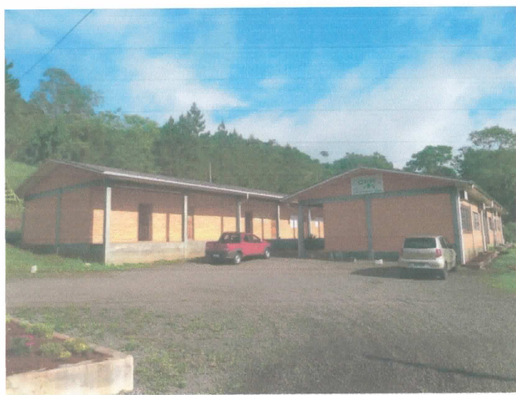
Figura 01: Visão externa da Casa Familiar Rural
