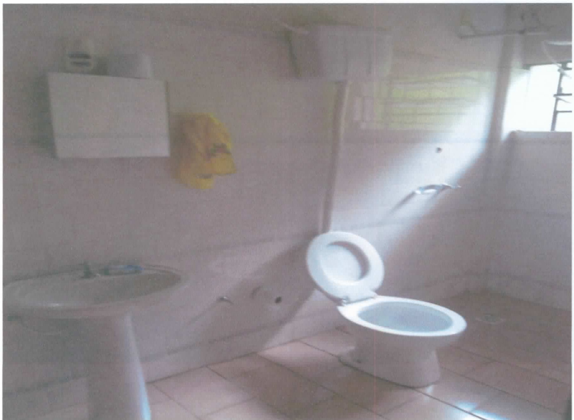
Figura 12: Alojamento com banheiro. Total de 06 alojamentos.
